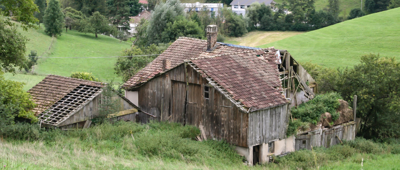
La ferme « Derrière les Crêts » avant rénovation
